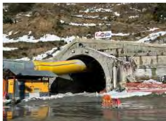
La nuova canna del traforo del Tenda sul lato italiano
